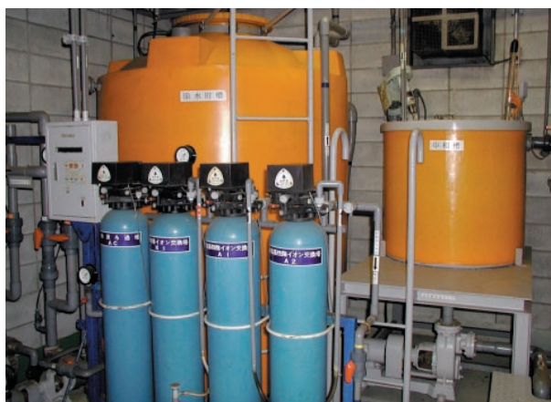
廃水処理施設
