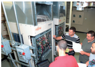
北米の高電圧規格に対応するため、ラインアップに追加したVRFの460V対応モデル（写真左）と現地での技術研修の様様（写真右）
