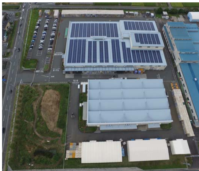
浜松事業所全景と富士エコサイクル（写真上部）の屋根に設置された太陽光パネル
