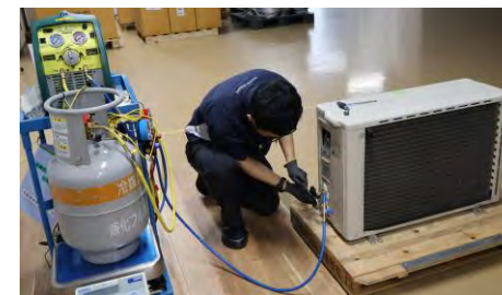
家庭用エアコンの冷媒回収作業
