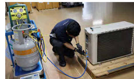
家庭用エアコンの冷媒回収作業
