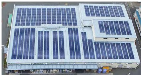
太陽光パネル (2017年12月稼働)
