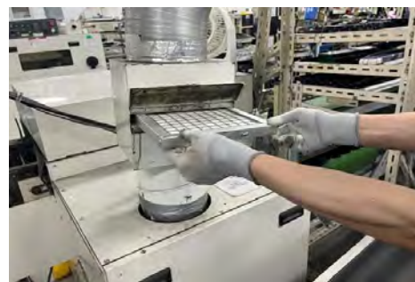
フィルター交換作業の様子
