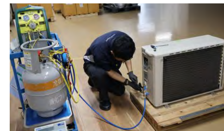
家庭用エアコンの冷媒回収作業
