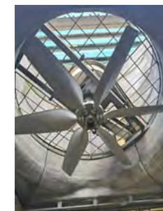
冷却塔の軽量プラスチックファン
