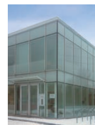
Fujitsu General (UK) Co., Ltd. (UK)
