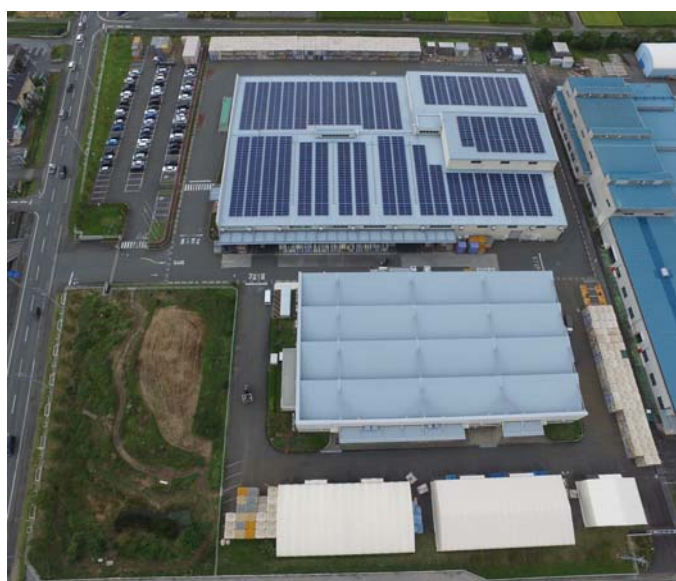
浜松事業所全景と富士エコサイクル（写真上部）の屋根に設置された太陽光パネル
